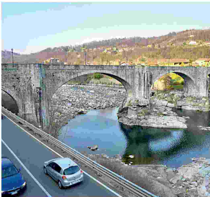
Il ponte di Agnona è stato realizzato tra il 1778 e il 1782
